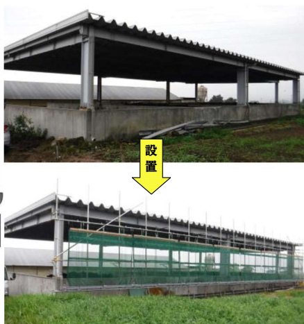
写真1 養鶏農家における設置状況
